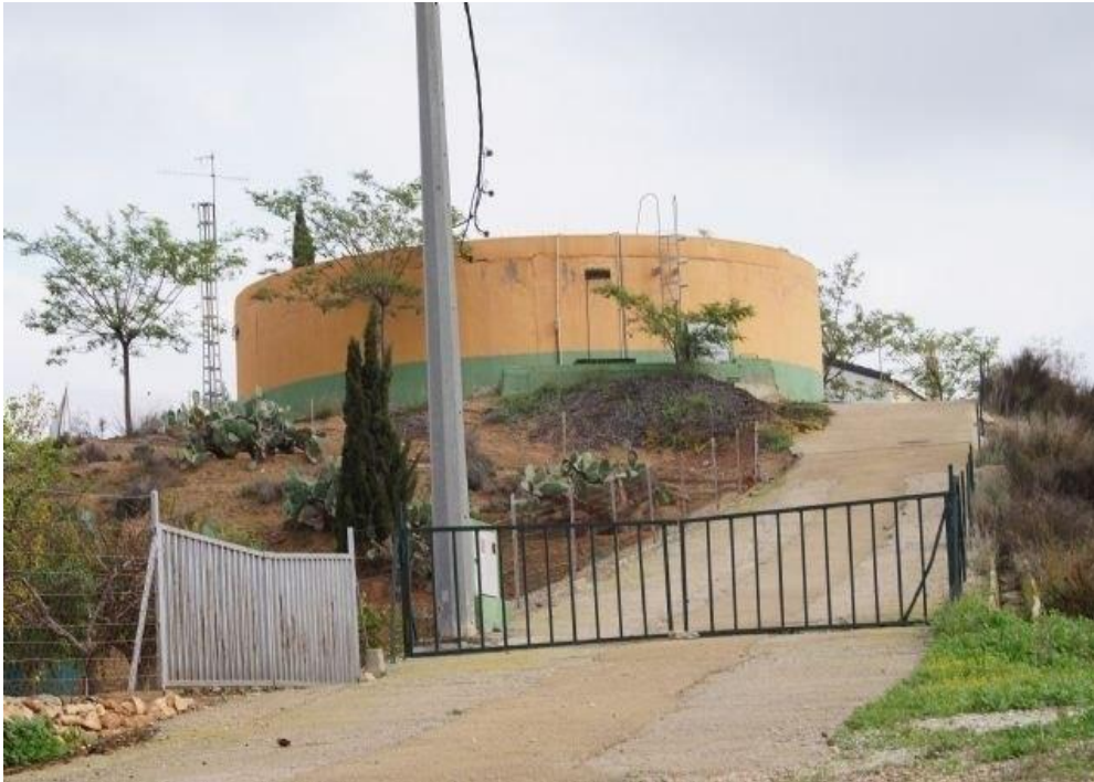
Depósito Paretón-Cantareros, Totana
