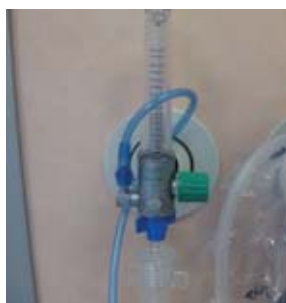
Figura 73. Caudalímetro de O 2 .
