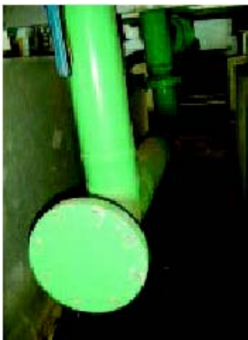
Figura 4. Tramo ciego de tubería (7)
